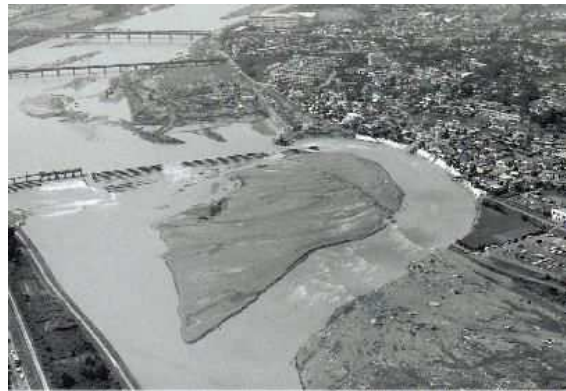
台風 16 号(昭和 49(1974)年)による被害
