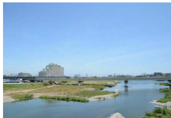
小田急線高架下周辺
