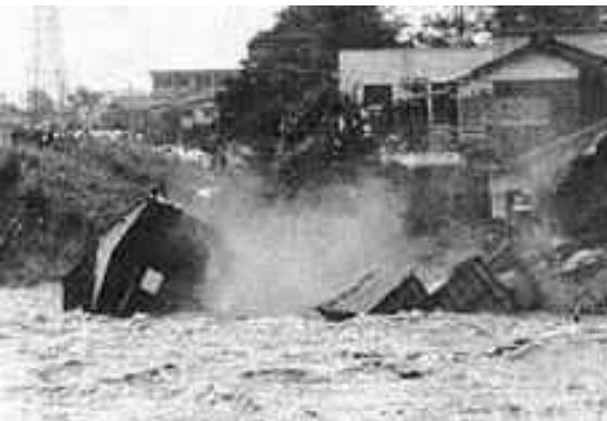
台風 16 号(昭和 49(1974)年)による被害
